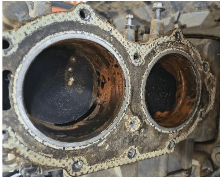
Gambar 4 Kondisi Liner Mesin Saat Pembongkaran
