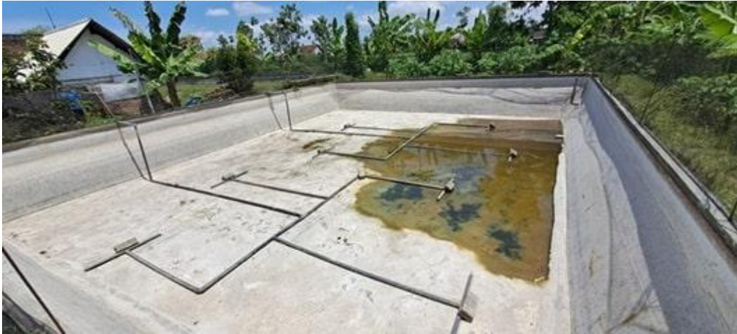
Gambar 3 Prototipe desain perpipaan MHSP pada kolam ukuran 10 x13 meter
