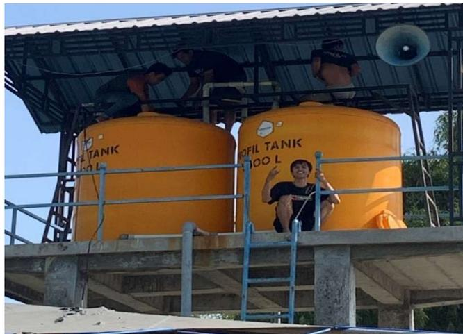
**Gambar 2.** Proses Pemasangan Sistem Filtrasi Anaerobik Menuju Tandon Air Bersih
