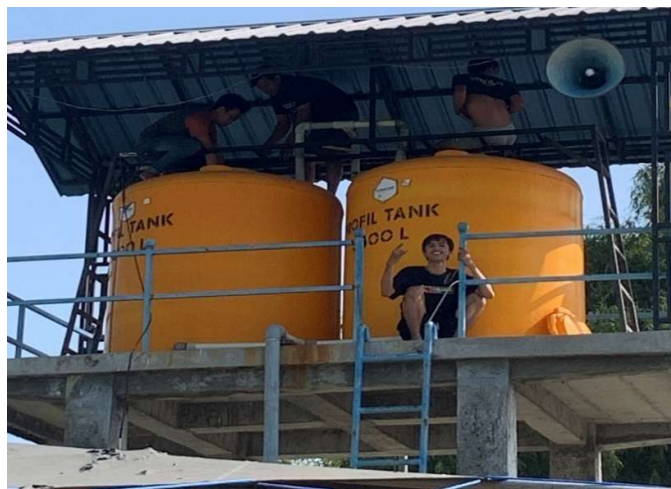
Gambar 2. Proses Pemasangan Sistem Filtrasi Anaerobik Menuju Tandon Air Bersih
