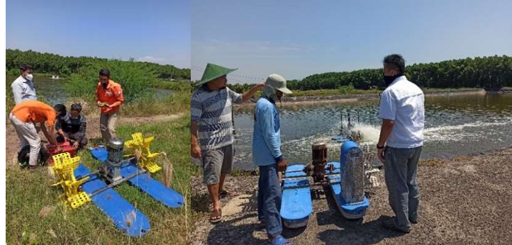
Gambar 4. Persiapan Pemasangan Kincir Air Baru dan Kincir Air Eksisting
