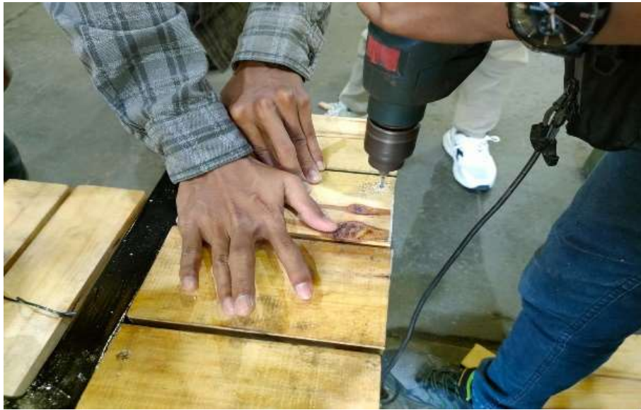
Gambar 6. Pemasangan Kayu yang sudah dipotong
