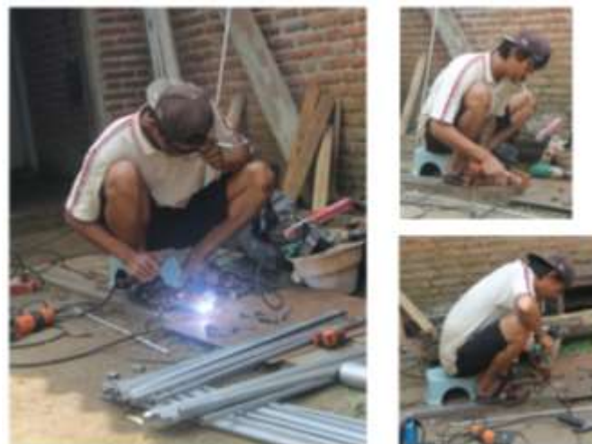
Gambar 2. Aktivitas warga dalam pekerjaan konstruksi dengan APD yang minim.
